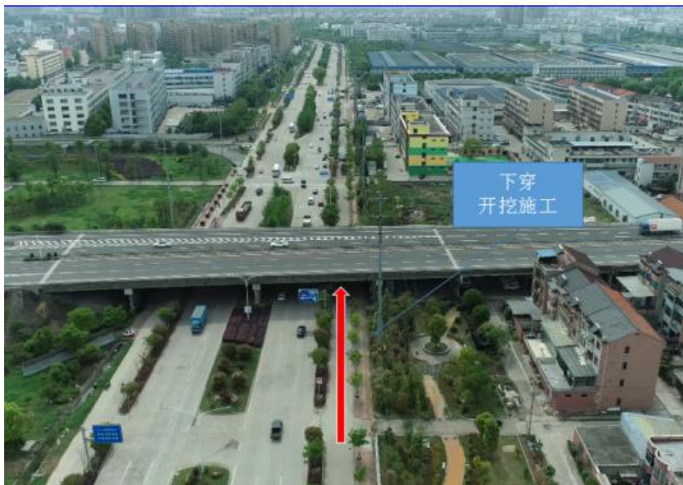
图 1-14 污水管穿越 G104 国道段，管线铺设于国道下方桥洞
