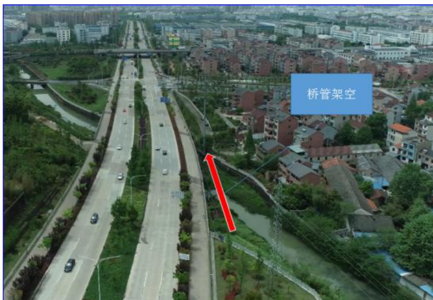
图 1-11 污水管穿越现状河道段，采用桥管架空施工
