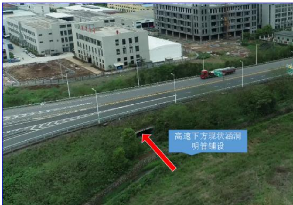
图 1-7 高速下方现状涵洞明管铺设
